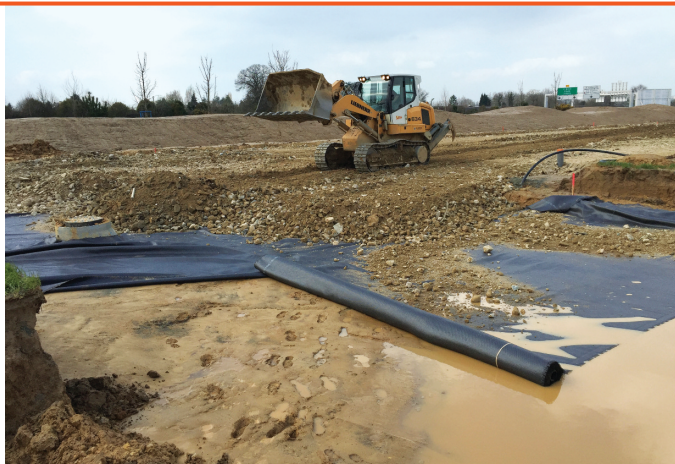
La solution TenCate Geolon® PP 60 assure à elle seule séparation et renforcement des plates-formes granulaires, deux fonctions essentielles pour les chantiers.
